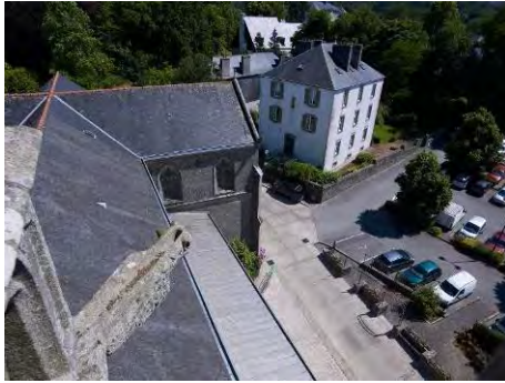
Le presbytère vu du clocher de l'église Saint-Idunet. © Région Bretagne.
