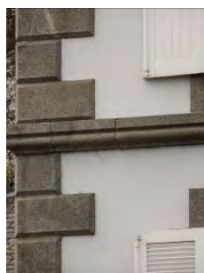
Rue Amiral Gaugen. Villa néo-gothique, néo-classique. 1877. Cordon filant et chaînage en granite.
