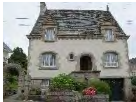
Lotissement de la Ville-Jouan. 1954 – 1971. Rues Saint-Idunet et Saint-Pol Roux. © Région Bretagne.
