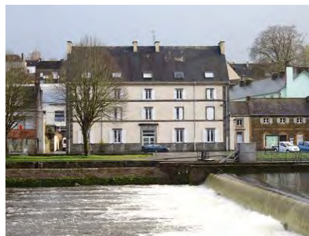
Ecluse de Châteaulin, n°236. 1818.
