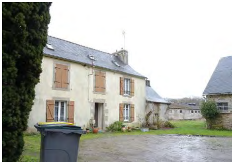
Maison de ferme tripartite à Penmez.
