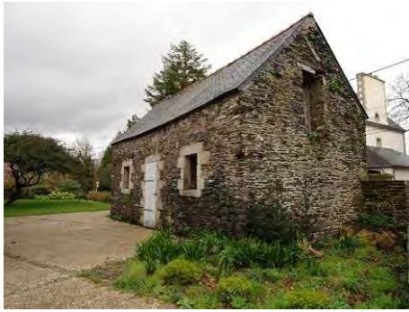
Coatigoff. Grange-étale à façade symétrique.
