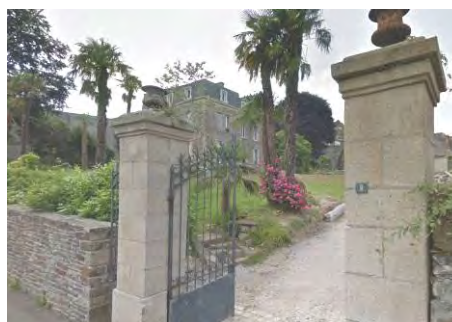
Maison Baley. 8, rue Raoul Anthony. 1897. Architecte, Albert Louppe. Maison de maître néo-classique.
