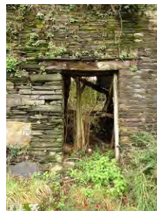
Enez-Penn-ar-Pont. Ancienne grange ? Porte à encadrement de moellons de schiste et linteau de bois abrité par un larmier en ardoises.
