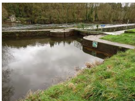
Egluse de Enez-Penne-ar-Pont, n°232. 1818 – 1828.
