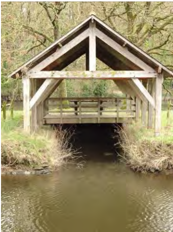
Abri à bateau. Ecluse de Enez-Penne-ar-Pont.
