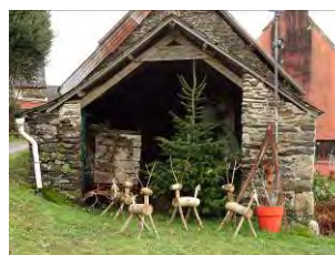
Kergudon. Grange (ou bucher ?) constituée de deux murs gouttereaux bas supportant une charpente à deux pans.
