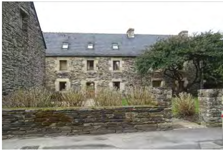
Ancien logis de la ferme de Coatigoff, 17 e siècle. Remanié au 19 e siècle.
