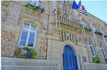
La mairie, architecte Charles Chaussepied-1912-1925
