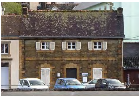
Maison éclusière. Quai Charles de Gaulle. 1820. Grès.
