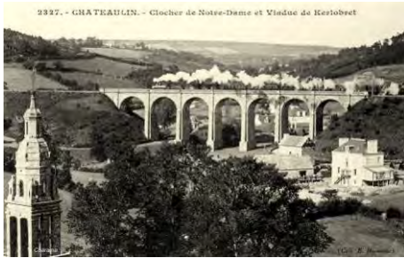
Viaduc de Kerlobret élevé en 1864.
