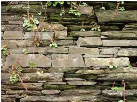
Parement dalles de schiste à Enez-Penne-ar-Pont
