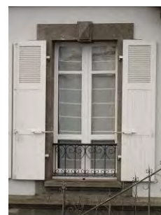
Rue Amiral Gaugen. Villa néo-gothique, néo-classique. 1877. Fenêtre à linteau orné d'une pointe de diamant.
