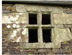
Kergudon. Fenêtre à meneau à arcs en accolade. 17 e siècle ?
