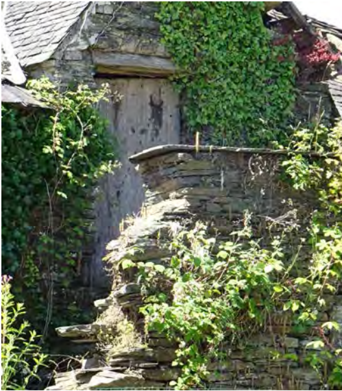
Linteau en bois et mur en moellons de schiste
