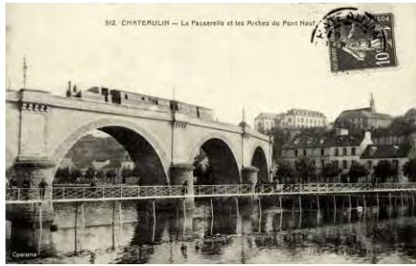
Le pont du chemin de fer, dit « pont neuf », 1906.
