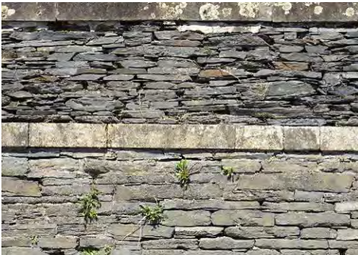
Exemple de mur en moellons plats de grès et de schiste
