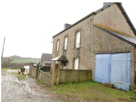
Maison de ferme tripartite à Mezambellec.
