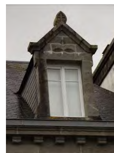
Rue Amiral Gaugen. Villa néo-gothique, néo-classique. 1877. Lucarne en pierre néo-gothique
