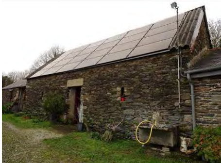
Kergudon. Grange-étale à façade symétrique.
