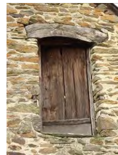
Enez-Penn-ar-Pont. Grange. Porte haute à encadrement de moellons de schiste et linteau de bois.
