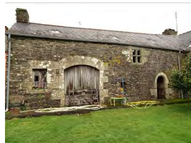
Kergudon. Logis à droite (17 e siècle ?) contigu au four à pain.
