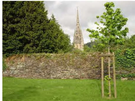
Mur de jardin d'un immeuble Grand Rue, réalisé en moellons de schiste allongés.
